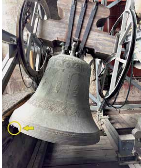
Die Glocke ist auf die Seite gekippt und wurde beschädigt.
